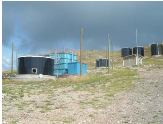
Figura B8. Planta de tratamiento de agua (actualmente en construcción)
