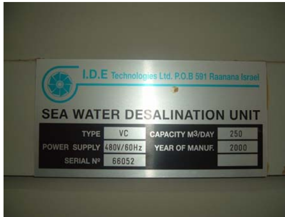
Figura B7. Datos de placa de la planta desalinizadora.
